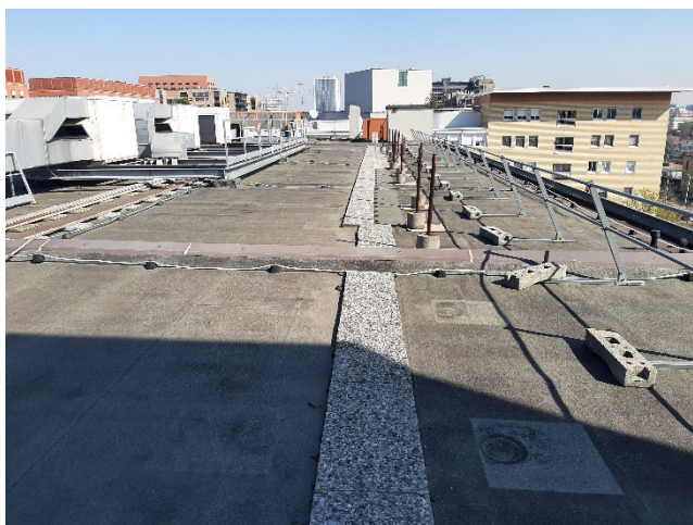
Figura 6 – Copertura - parapetto provvisorio esistente
