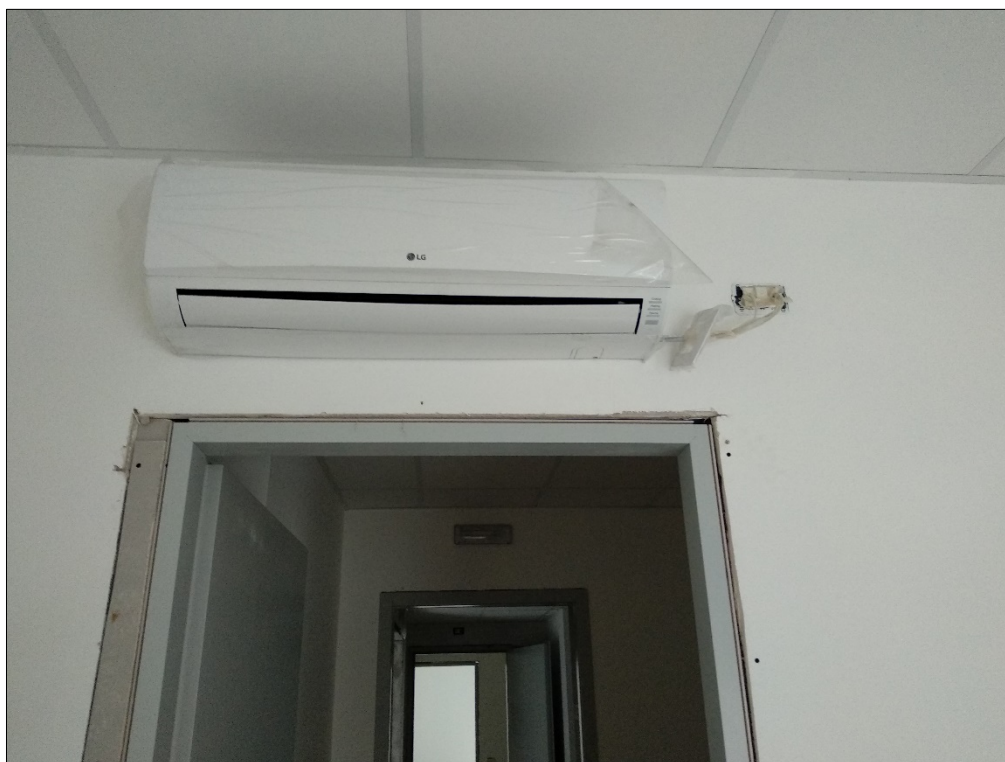
Fig. 51 – Unità interne raffreddamento/riscaldamento
