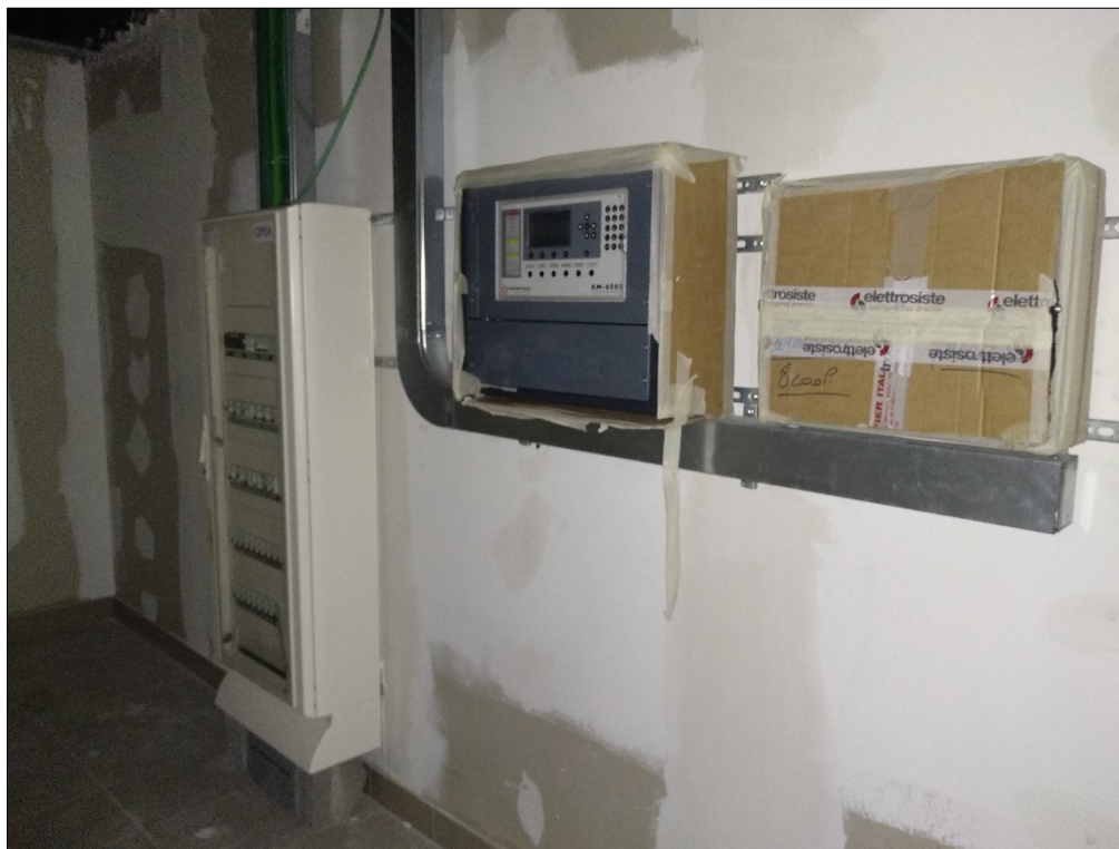
Fig. 55 – Centralina allarme antincendio
