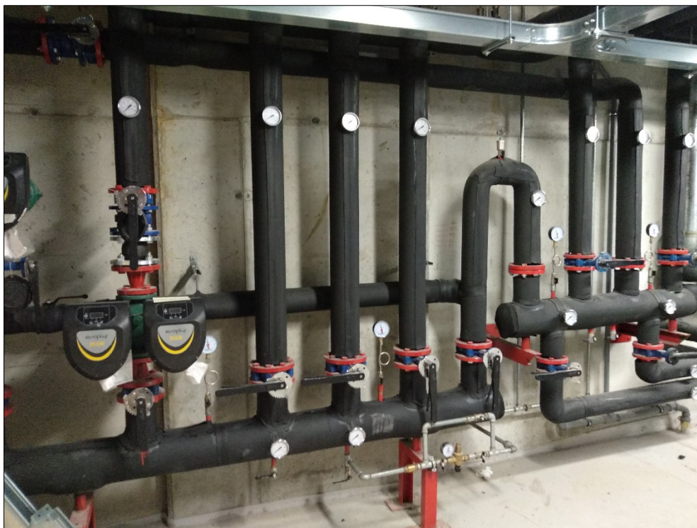
Fig. 48 – Sottosistema di distribuzione riscaldamento
