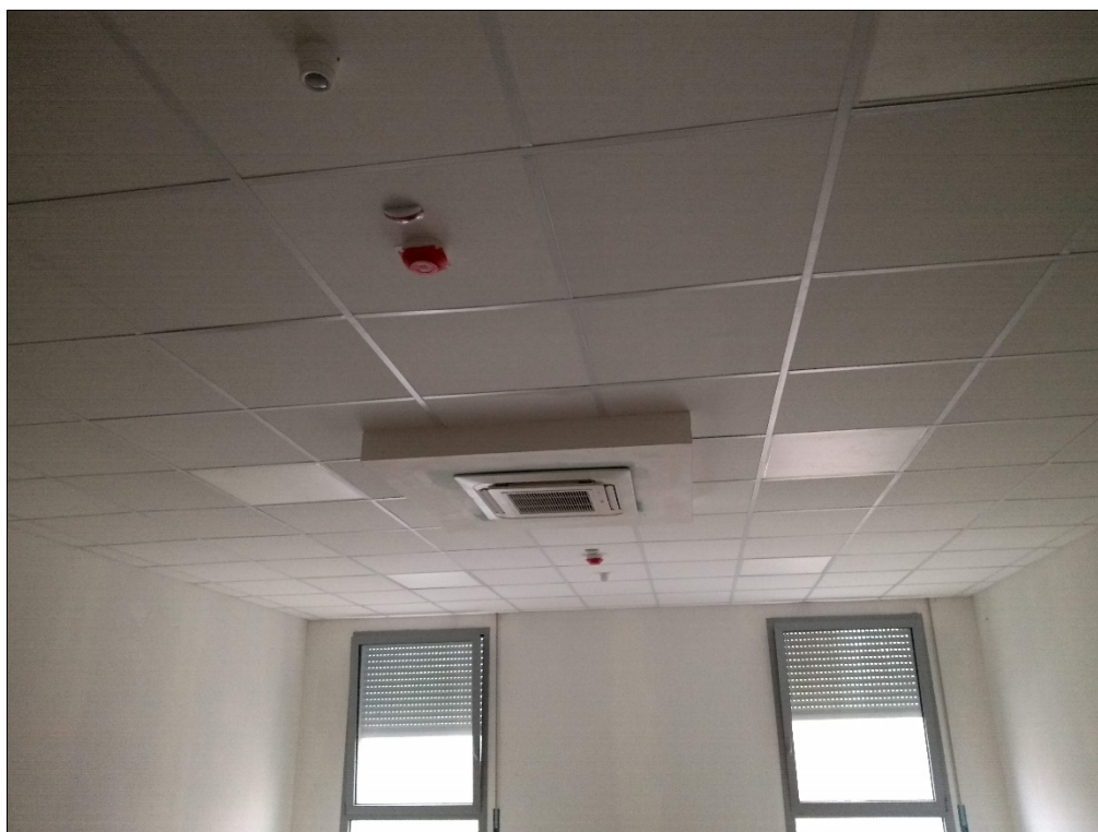
Fig. 54 – Sistema rivelazione fumi
