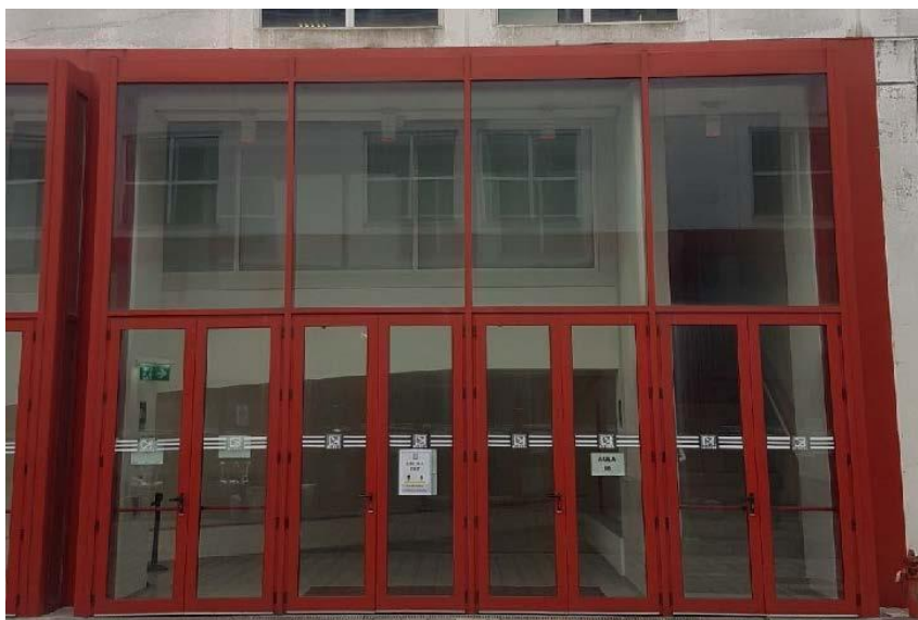
Figura 12 - Il sistema a facciata continua esistente
